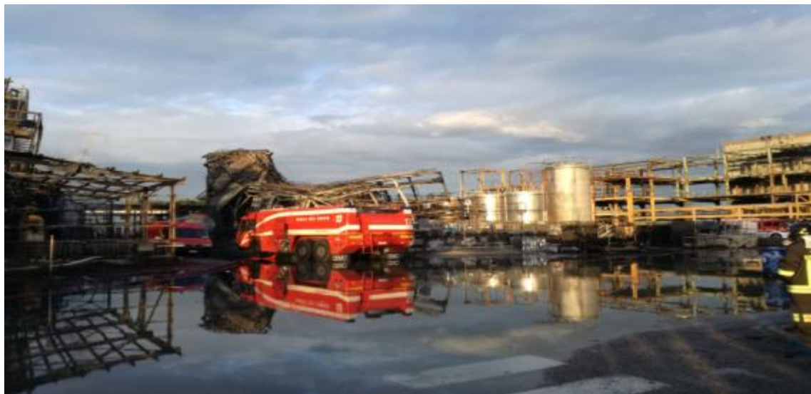
Figura 2: Incendio 3V Signa Porto Marghera (VE) – 15/05/2020
