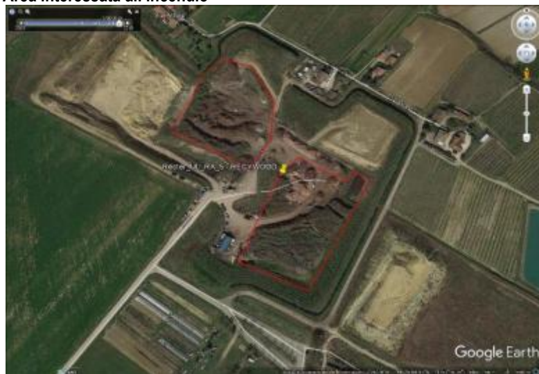
Area interessata all'incendio
